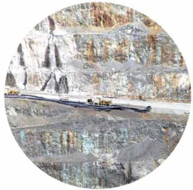
รูปที่ 5. สภาพท่อที่ผ่านการลากในเหมืองเพื่อการติดตั้ง Pipe conditions after being dragged into the mining pit for installation
