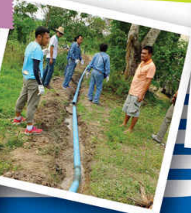
โครงการต่อเติมหลังคาและสร้างห้องน้ำศาลเจ้าแม่เกษฯ
